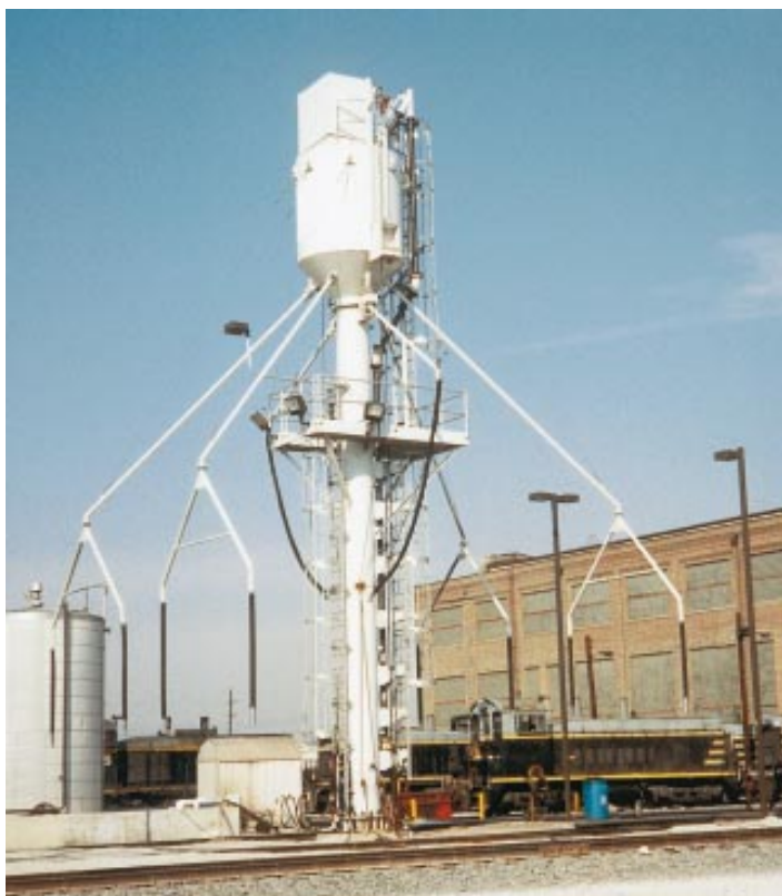
铁路线运沙系统
