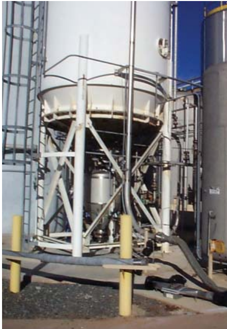
Descarregadores de silo & sistema de transporte
