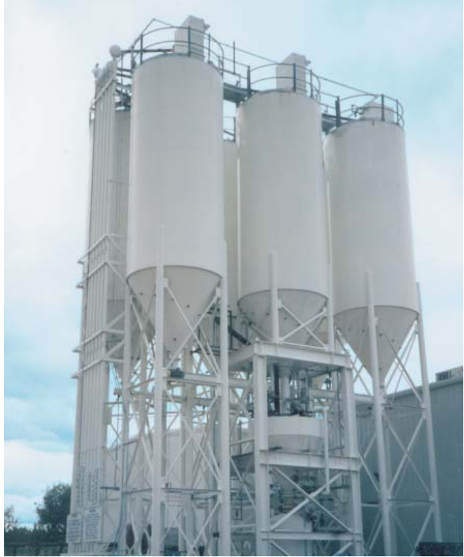
称重/配料及传输系统，包括存储仓及钢结构
