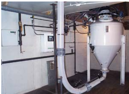
传输谷物的全线概念的气力输送系统
