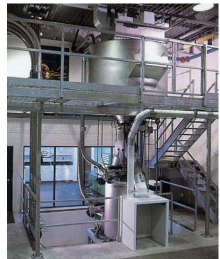
Installation d'essais en vraie grandeur.
