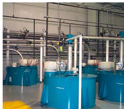
Zespół zbiorników wyrównawczych o pojemności 20 stóp (0,6 m 3 ) wyposażone w filtry odpowietrzające Modu-Kleen™ 669
