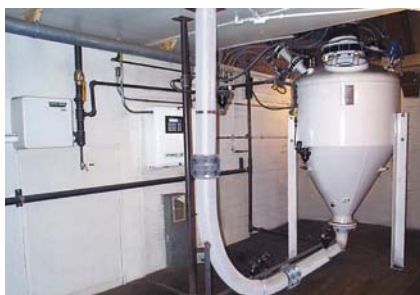
Konceptja Pelnej Linii™ pneumatycznego systemu przenoszenia kukurydzy
