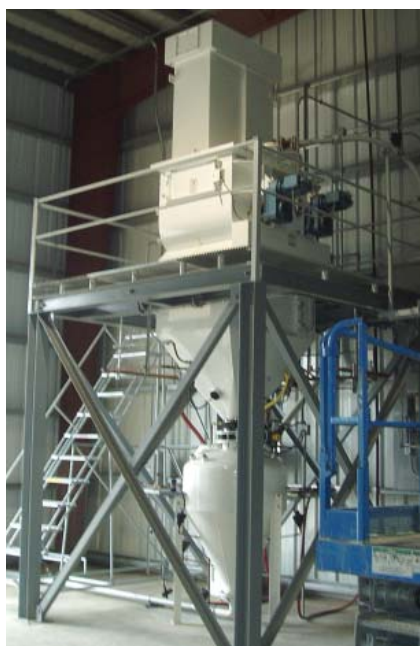
Sistemas de mezcla y transporte
