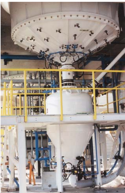
Transportador en fase densa y descarga fluidificada de silo Vibra-Jet™ para detergentes
